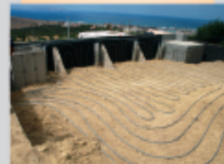
Κλειστό Οριζόντιο Γεωθερμικό πεδίο
