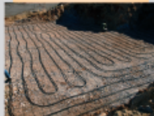
Κλειστό Οριζόντιο Γεωθερμικό πεδίο
