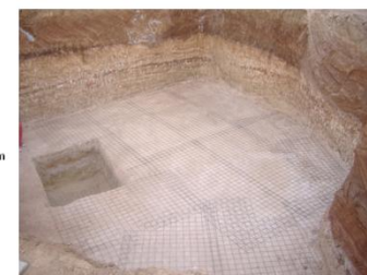
ΤΟΠΟΘΕΤΗΣΗ ΤΟΥ ΣΥΣΤΗΜΑΤΟΣ ΕΝΔΟΔΑΠΕΔΙΑΣ ΘΕΡΜΑΝΣΗΣ - ΔΡΟΣΙΣΜΟΥ
